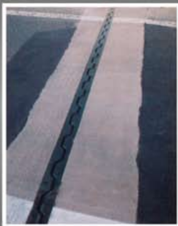
橋梁の段差補修例(施工時間約10分)
