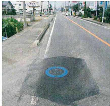
交差点周辺タイヤ据え切り部補修 目的：耐流動、破損対策 交通量：不明 撮影日：施工後 1 年 0 か月経過時
