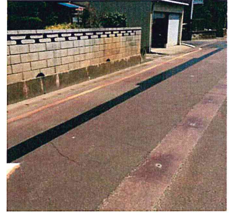
市道アスファルト舗装打ち継目補修 目的：ひび割れ拡大抑制、止水 交通量：不明 撮影日：施工後 1 年 0 か月経過時
