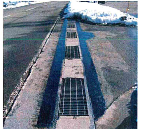
民間工場出入口U字溝周り段差補修 目的：ひび割れ抑制、段差解消 交通量：不明 撮影日：施工後 0 年 6 か月経過時
