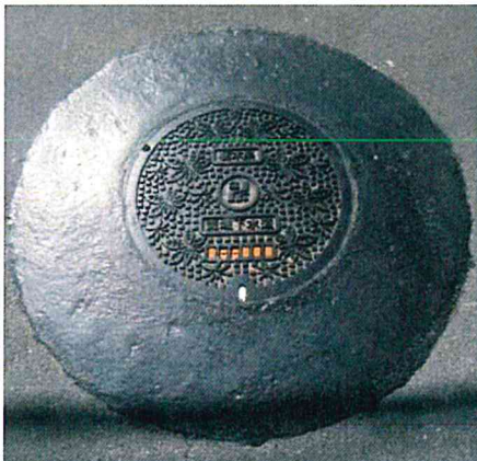
一般国道マンホール蓋周辺補修 目的：ひび割れ抑制、段差解消 交通量：約 10,000 台 / 日 撮影日：施工後 1 年 0 か月経過時
