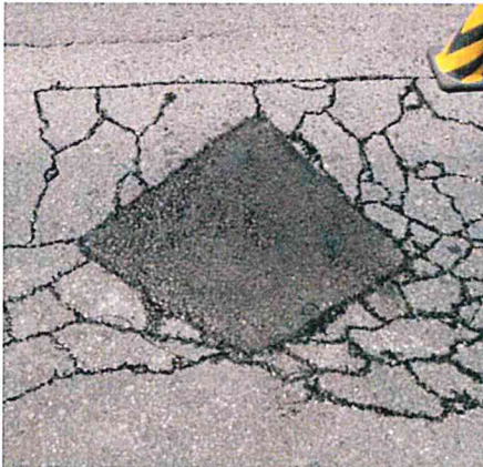
一般国道ポットホール補修（重交通路線） 目的：ポットホール抑制 交通量：約 20,000 台 / 日 撮影日：施工後 3 年 6 か月経過時
