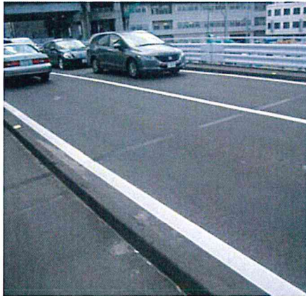
国道 45 号線仮設橋梁目地 目的：ひび割れ抑制 交通量：約 50,000 台 / 日 撮影日：施工後 4 年 0 か月経過時
