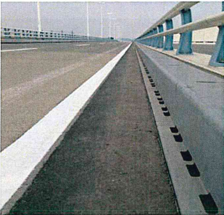
鋼床版橋地覆端部止水処理 (ゲース代替) 目的：ひび割れ抑制、止水 交通量：不明 撮影日：施工後 1 年 0 か月経過時
