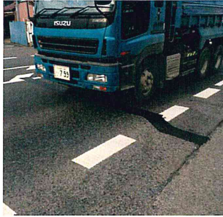
一般国道リフレクションクラック補修 目的：ひび割れ抑制 交通量：約 10,000 台 / 日 (渋滞路線) 撮影日：施工後 6 か月経過時
