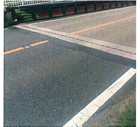
一般国道橋台背面段差修正補修 目的：ひび割れ抑制、段差解消 交通量：約 15,000 台 / 日 撮影日：施工後 0 年 6 か月経過時
