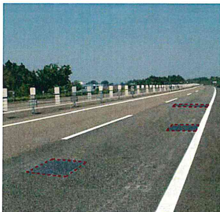
高速道路舗装部分修繕 目的：ポットホール抑制、破損対策 交通量：約 10,000 台 / 日 撮影日：施工後 5 年 0 か月経過時
