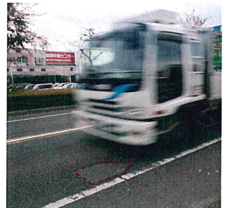
県道ポットホール補修（重交通路線） 目的：ポットホール抑制 交通量：約 50,000 台 / 日 撮影日：施工後 4 年 0 ケ月経過時
