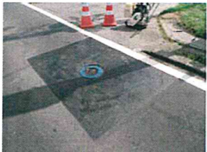
交差点付近 (タイヤ据切部) の補修
