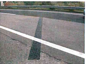
高速道路路面の帯水処理
