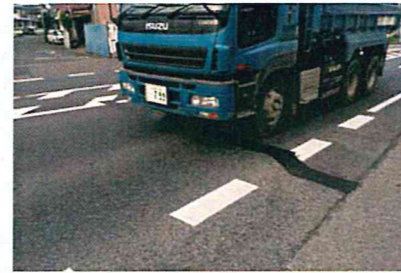
重交通路線の補修例
